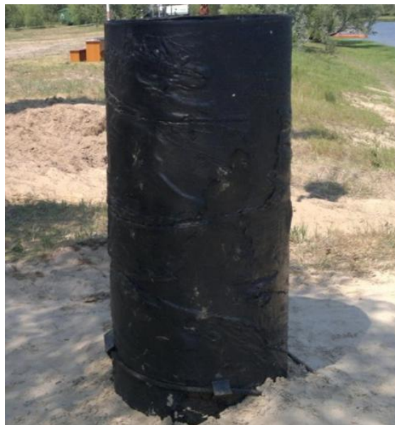
Рисунок 3.1 - Якорь свайного типа
